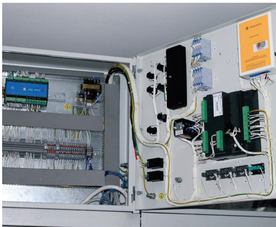
Блок релейной защиты ячейки КСО-215
