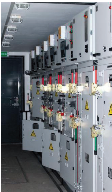
Распределительное устройство на базе ячеек КСО-215
