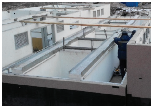
Поддоны и ж/б станины в камерах трансформаторов КТПМ 2x12500/35 (КТПМ в процессе монтажа, верхние модули и перегородка между камерами трансформаторов не установлены)
