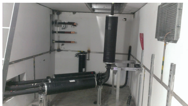
Кабельный прямой КТПМ (КТПМ в процессе монтажа)
