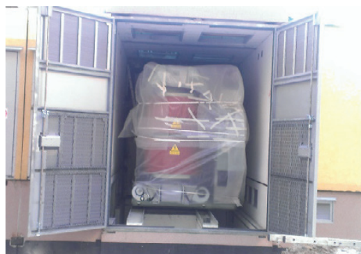
Камера трансформатора КТПМ 2x12500/35 (КТПМ в процессе монтажа)
